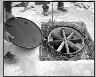
สวมฝาก่อนการเทคอนกรีต
