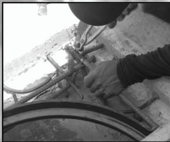
เริ่มติดตั้งเฟรมเข้ากับเหล็ก โครงสร้างเดิม
