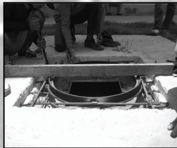
เซตระดับเฟรมให้อยู่ในระดับเดียวกับพื้นถนน (Finishing)
